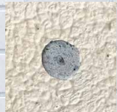
塗膜剥離状態
