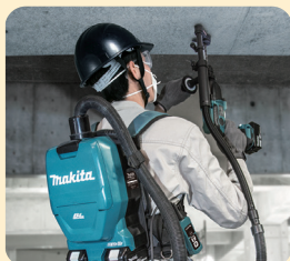
●コンクリート穴あけ
