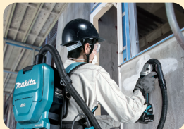
●コンクリート研削
