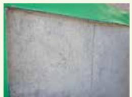
塗膜はく離後、再塗装する塗料に適する素地調整程度を検討します。残存した塗膜がある場合、除去方法を検討します。
