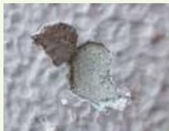
既存塗膜塗重ね構成、塗替え回数を確認します。
