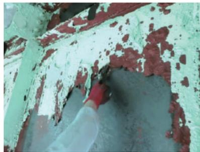
スクレーパーによる剥離作業
