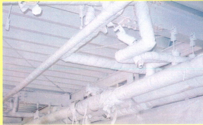
アスキャッチ CW 塗布 (白色仕上げ)
