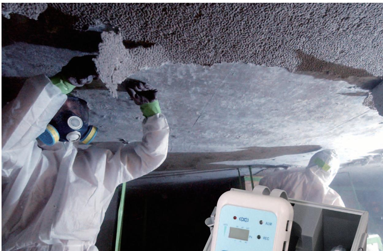
アスベストやダイオキシンを除去する隔離室など、内部の空気を外に漏らさない陰圧ルームの微圧を監視する装置です。
