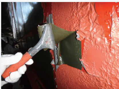
手工具による塗膜はく離作業状況
