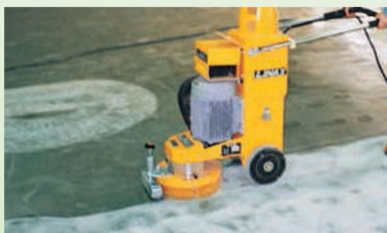
強化コンクリートの目荒し
